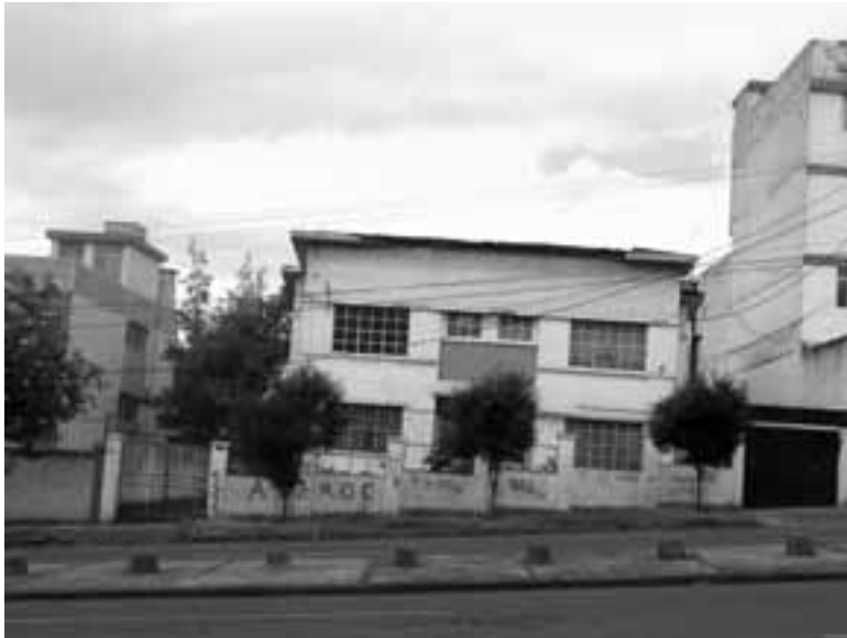
Casa de Seguridad de la Avenida Universitaria y El Oro
