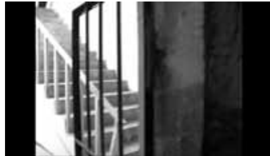
Corredor estrecho del Comando Azuay N° 6
