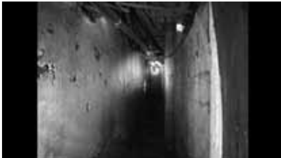
Vista interior del Comando Azuay N° 6
