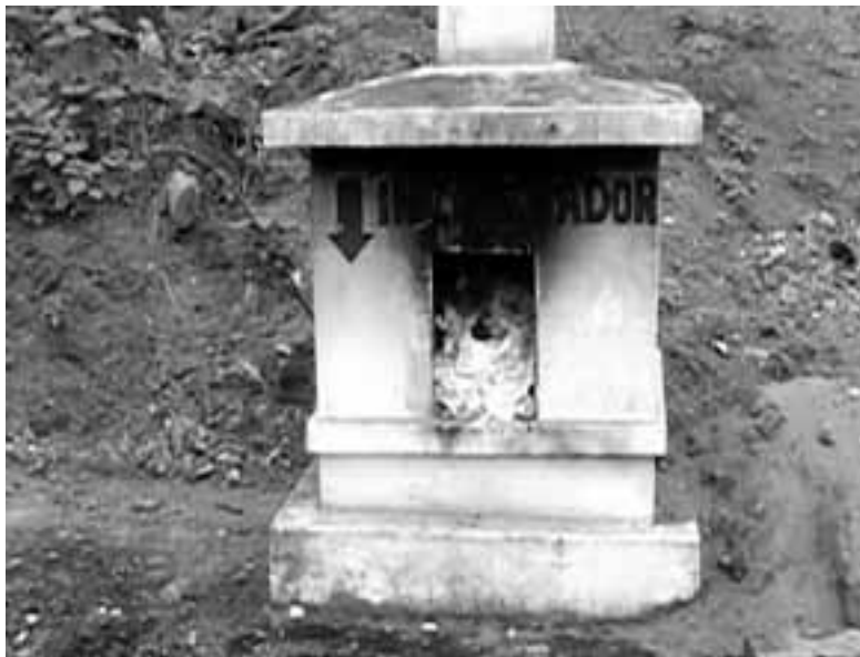
Horno incinerador del destacamento de inteligencia en Esmeraldas.
