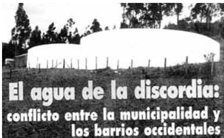
Tanques del sistema de agua entubada del sector del Plateado. Publicación sin referencia.
